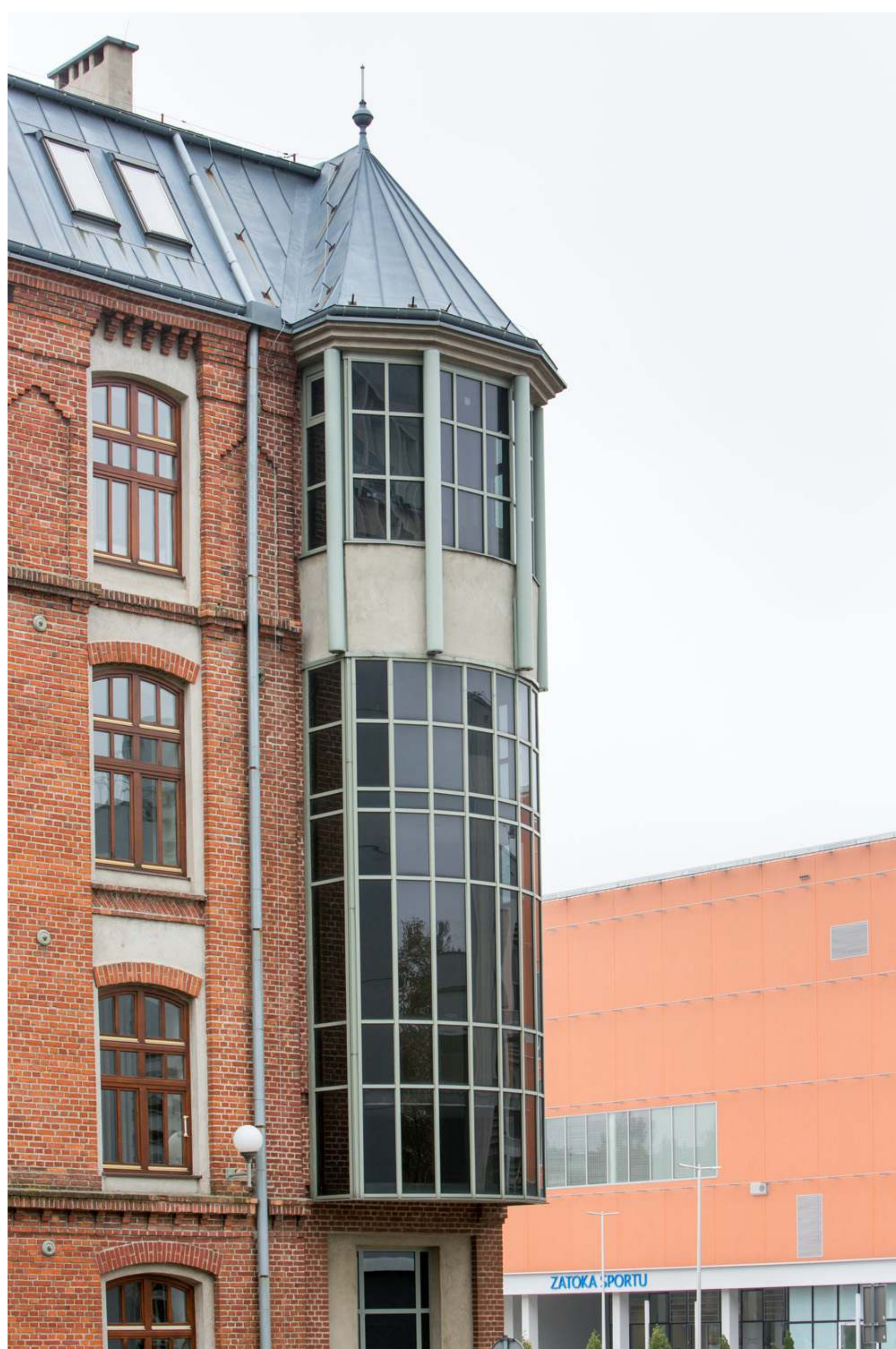
Budynek Trzech Wydziałów Politechniki Łódzkiej. Pofabryczny obiekt mieszczący się przy ul. Wólczyskiej 215. Podczas przeprowadzonej przez Politechnikę Łódzką rewitalizacji budynek wzbogacono o takie detale jak nowoczesne, przeszklone wykuszne zwieńczone blaszanymi hełmami.
