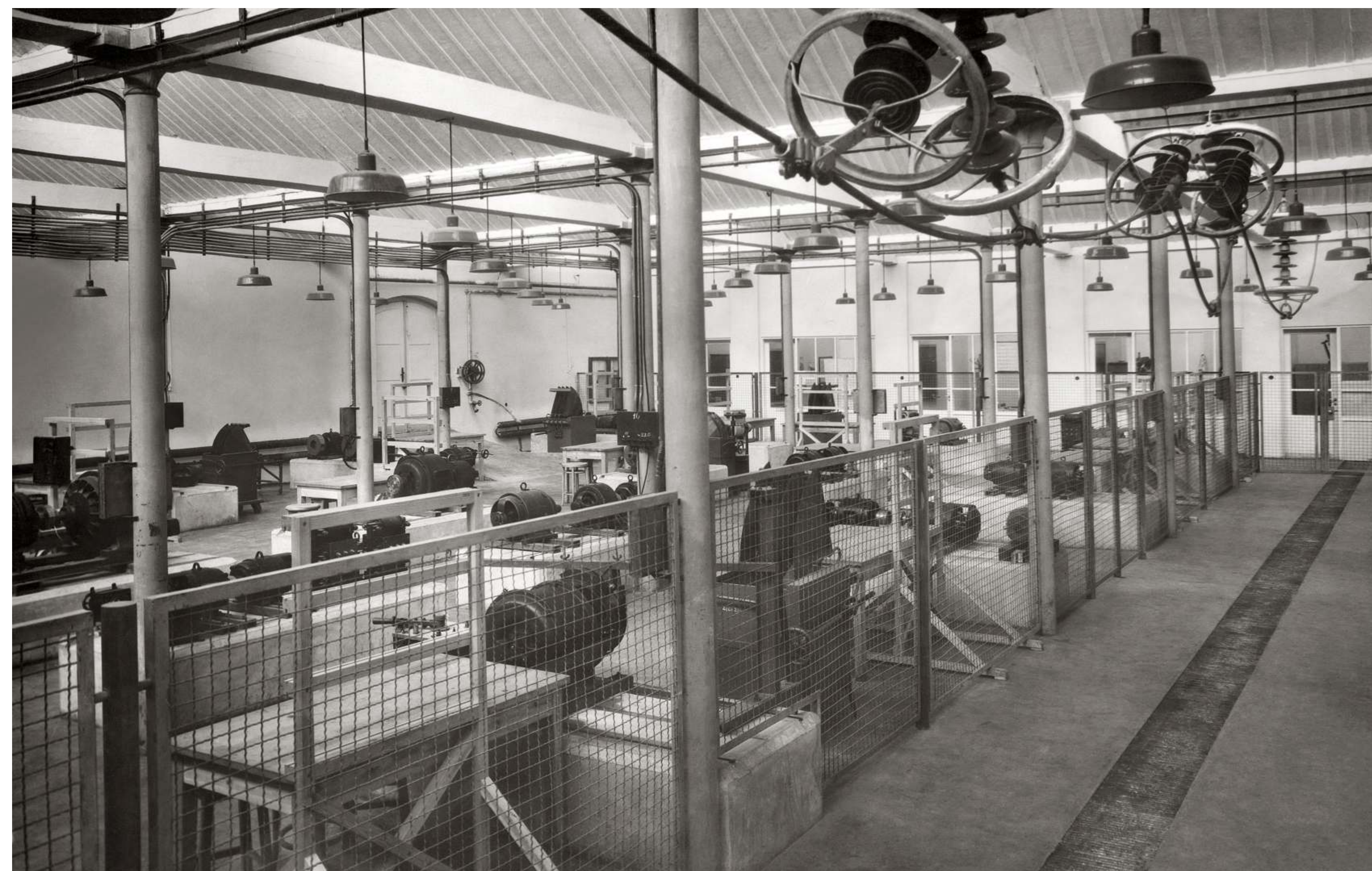
Fragment laboratorium Zakładu Maszyn Elektrycznych Wydziału Elektrycznego, w którym prowadzono prace nad zagadnieniami związanymi z konstrukcją, eksploatacją i pomiarami transformatorów oraz maszyn asynchronicznych, synchronicznych i prądu stałego. 1948 rok
