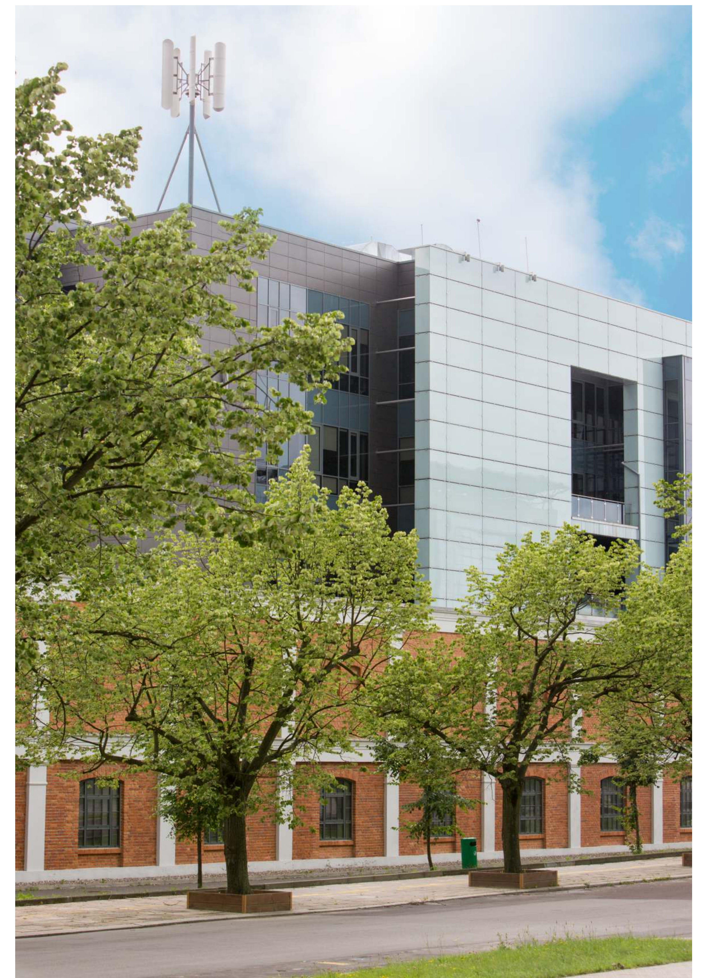
Fabryka In ynierów XXI wieku Politechniki Łódzkiej. Nowoczesny obiekt dydaktyczno-laboratoryjny Wydziału Mechanicznego. W pi ciokondygnacyjnym budynku znajduj si : 22 laboratoria, 5 sal wykładowych, 8 sal seminaryjnych, 26 pracowni dydaktycznych i dydaktyczno-laboratoryjnych, 5 pracowni informatycznych oraz 3 sale teleinformatyczne.
