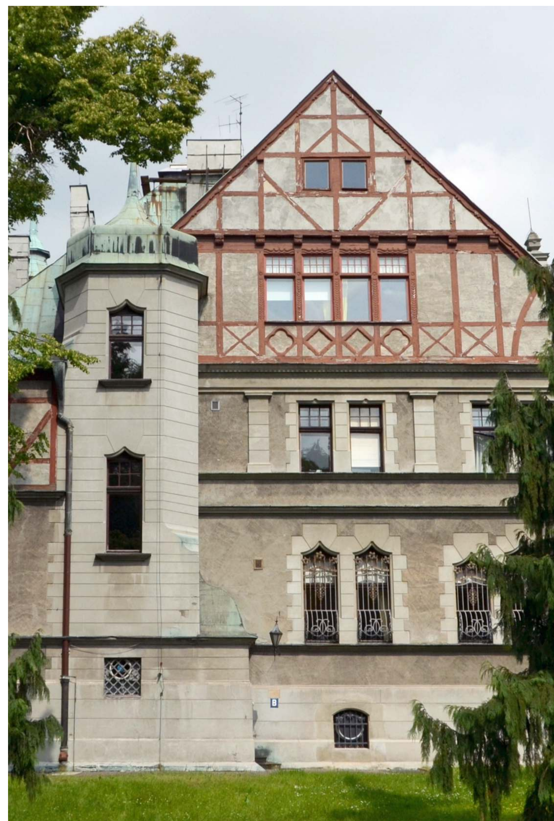
Pierwsza siedziba Wydziału Budownictwa Łódzkiego, ul. Ks. J. Skorupki 6/8. Willa Reinholda Richtera - elewacja zachodnia z trójkątnym, ryglowym szczytem.
