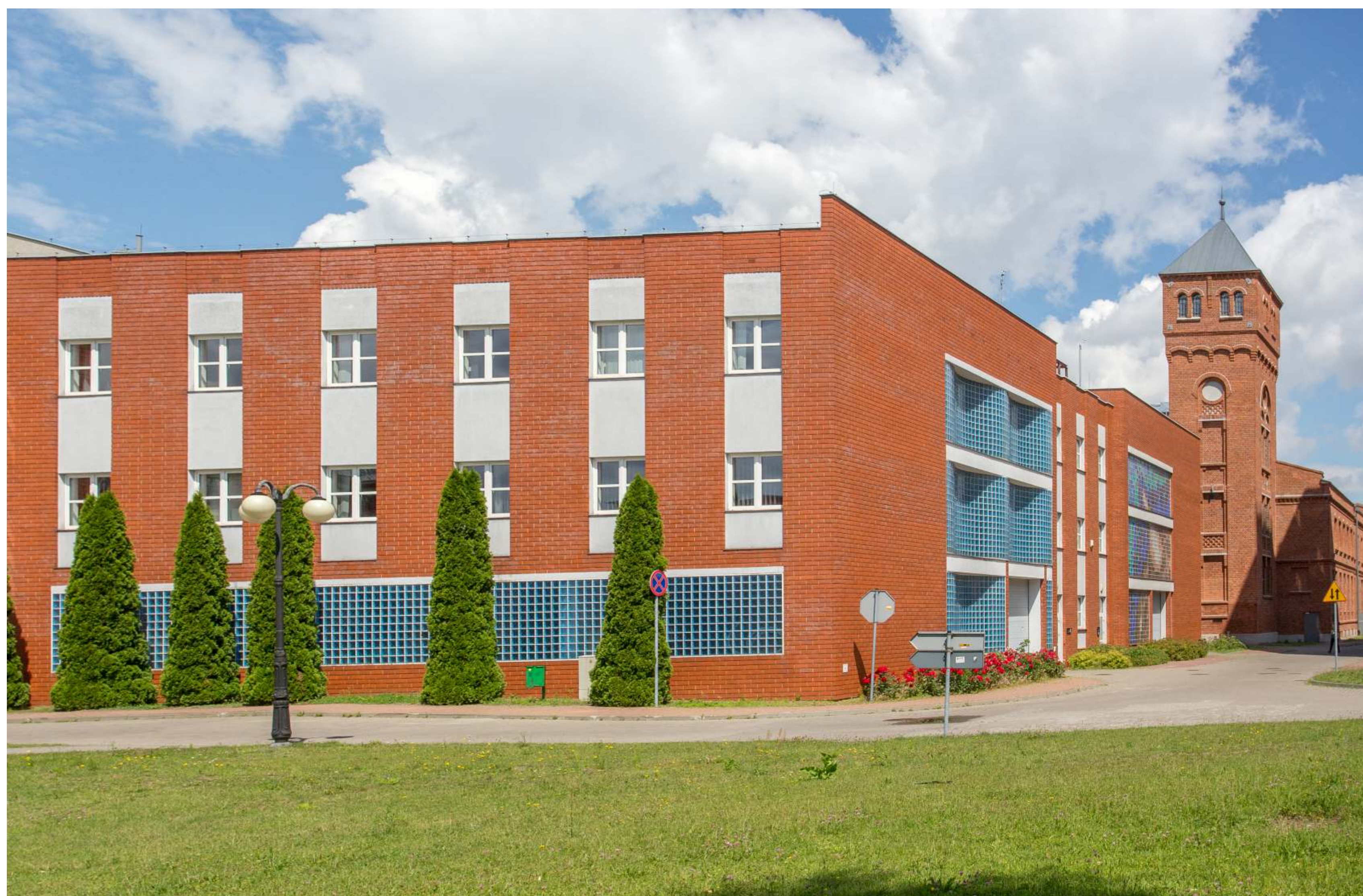
Instytut Maszyn Przepływowych Wydziału Mechanicznego Politechniki Łódzkiej, ul. Wólcza ska 219/223. Budynek został przebudowany i rozbudowany dla potrzeb Instytutu w 2002 roku.
